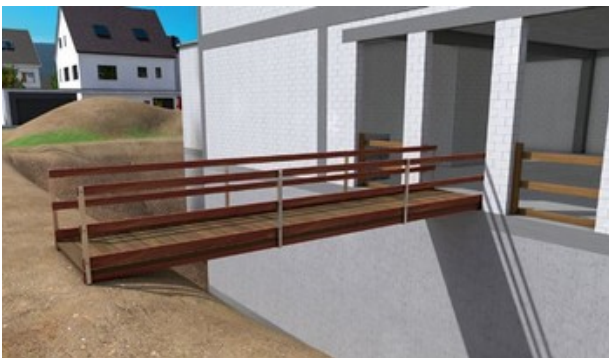
Abb. 7 Laufsteg mit Trittleisten (wegen Rutschgefahr) und Seitenschutz
