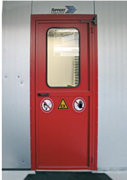
Abb. 18 Kennzeichnung an einem Zugang zum Lackiererraum
