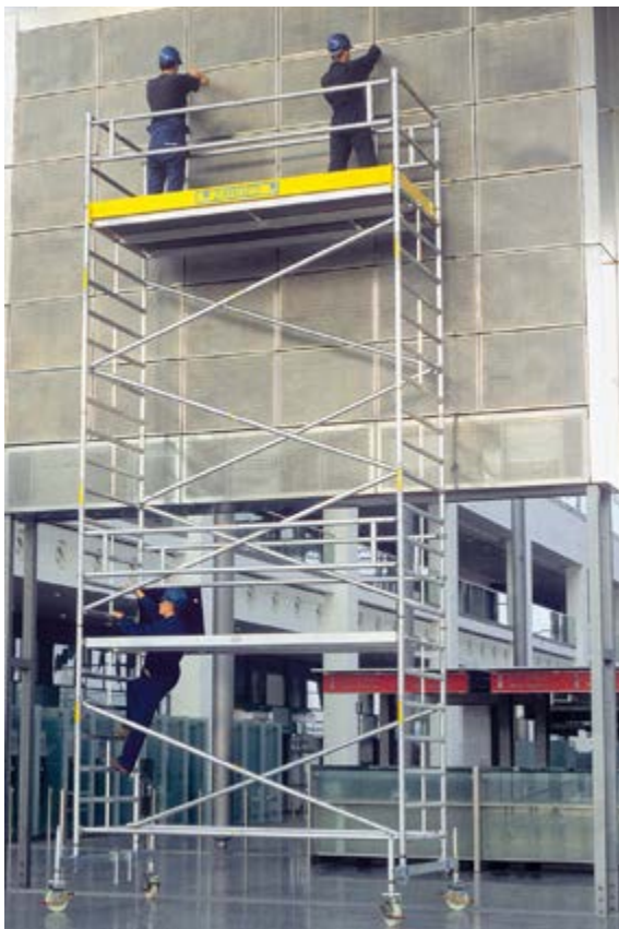
Abb. 4-17 Korrekt aufgebaute fahrbare Arbeitsbühne
