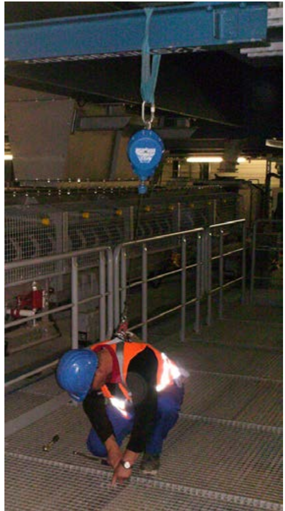
Abb. 4-16 PSA gegen Absturz mit Höhensicherungsgerät
