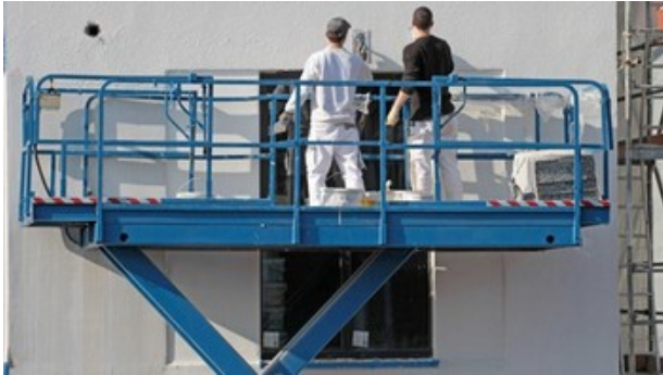
Abb. 28 Fassadenarbeiten mit Materialtransport
