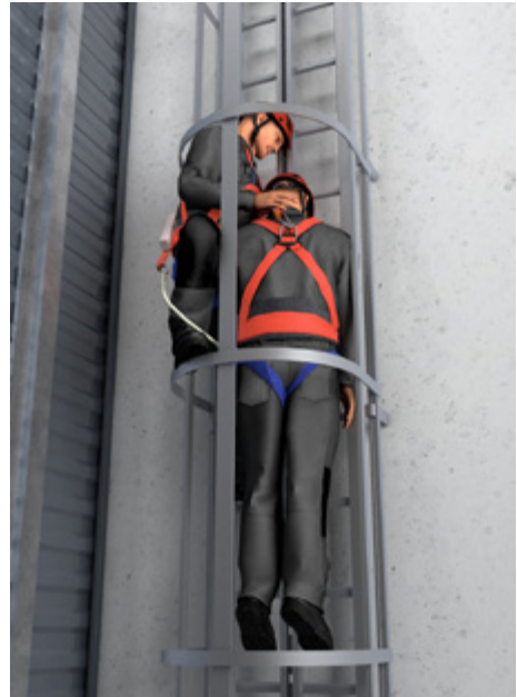
Abb. 12 Erschwerte Rettung einer Person von einer Steigleiter mit Steigschutz bei zusätzlich montiertem Rückenschutz
