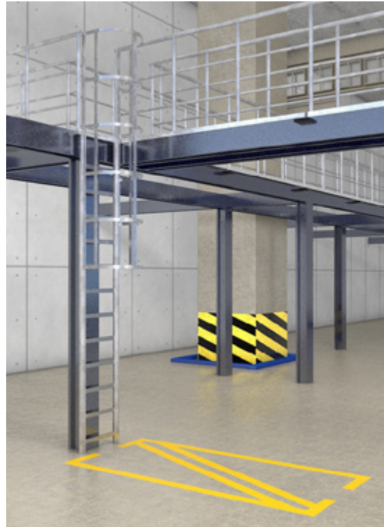
Abb. 10 Gekennzeichnete Bereich, der stets frei zu halten ist
