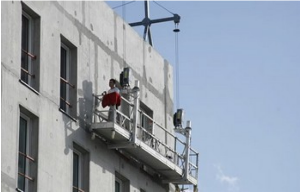
Abb. 14 Hochziehbares Personenaufnahmemittel bei Arbeiten an einer Fassade
