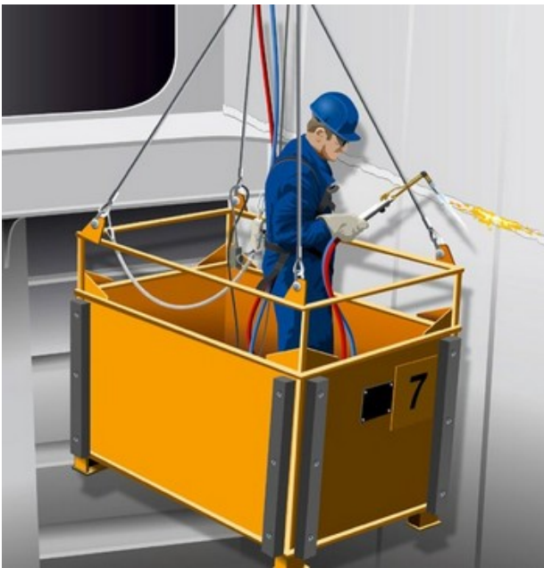
Abb. 15 Hochziehbares Personenaufnahmemittel am Kran hängend
