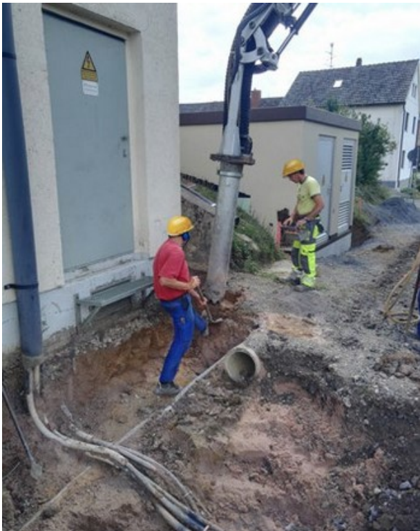
Abb. 4 Saugrohr eines Saugbaggers im Einsatz
