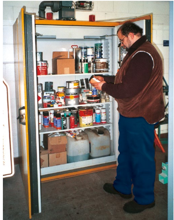
Abb. 2 Lagerung entzündbarer Flüssigkeiten in einem Sicherheitsschrank
