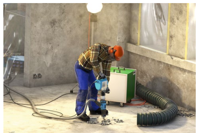
Abb. 13 und 14 Verwendung geprüfter, abgesaugter Bearbeitungssysteme
