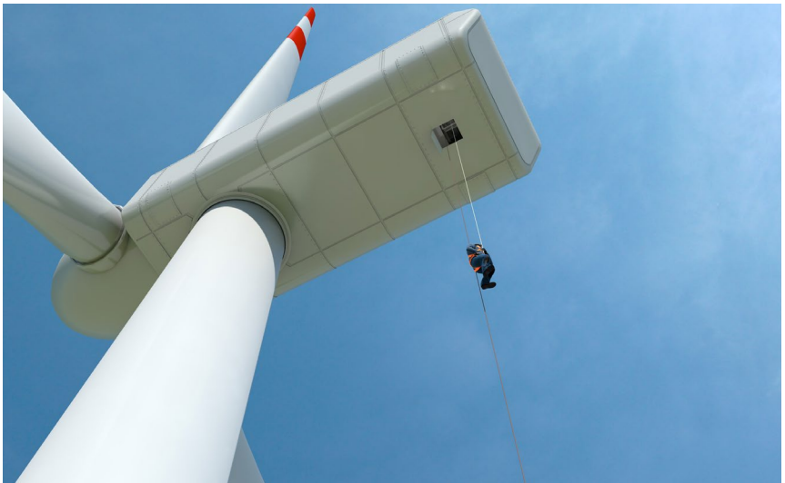
Abb. 8 Rettung aus dem Maschinenhaus
