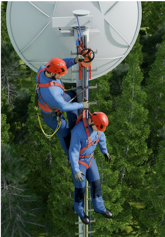
Abb. 16 Abseilgerät mit integrierter Hubeinrichtung (Passivrettung)
