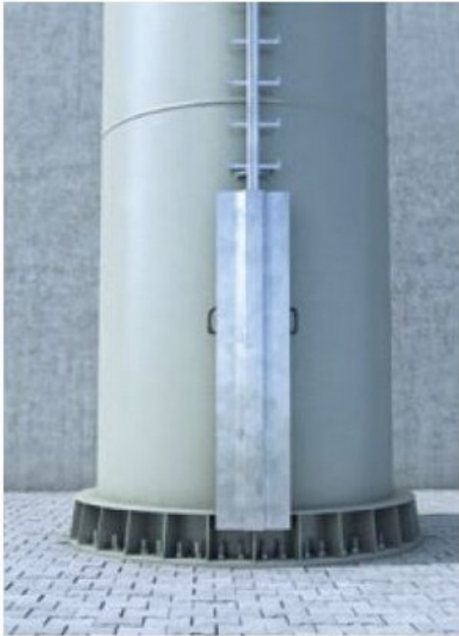
Abb. 5 Steigleiter bis zum Boden geführt und gegen unbefugte Benutzung gesichert
