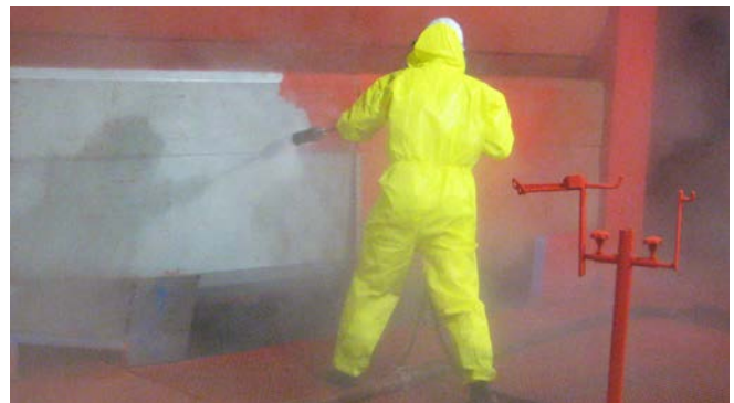
Abb. 20 Reinigung mit einem manuellen Hochdruckreiniger
