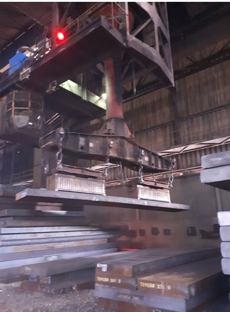
Abb. 6 Brammentransportkran mit Magnet
