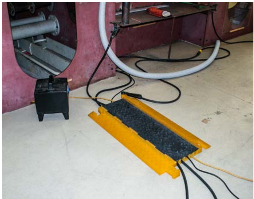
Abb. 3-4 Sicherung der Schweißleitung gegen Beschädigung beim Überfahren.
