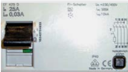
Abb. 3-5 30 mA FI-Schutzschalter – RCD (englisch: residual current protective device)
