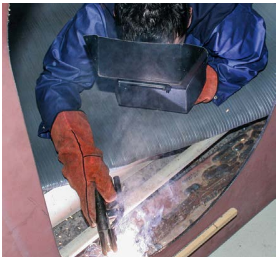
Abb. 5-2 Lichtbogenschweißen unter erhöhter elektrischer Gefährdung mit Hilfe isolierender Zwischenlage
