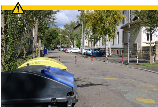
Abb. 10 Durch Absperrung mit Pfosten sind hier zwei Sackgassen entstanden, die keine geeignete Wendemöglichkeit bieten.
