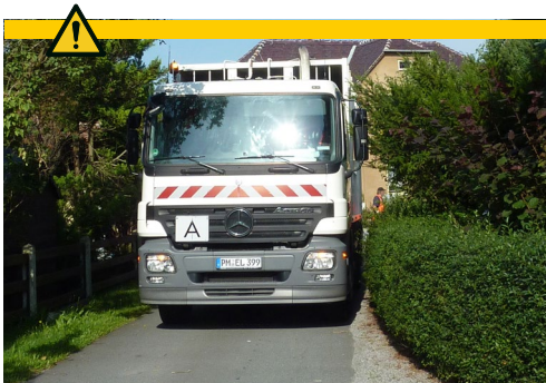
Abb. 2 Eine ausreichende Breite für eine sichere Fahrt ist hier nicht gegeben.
