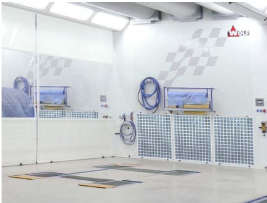
Abb. 5 Vorbereitungsplatz mit diagonaler Luftführung (senkrechte wandseitige Absaugung)
