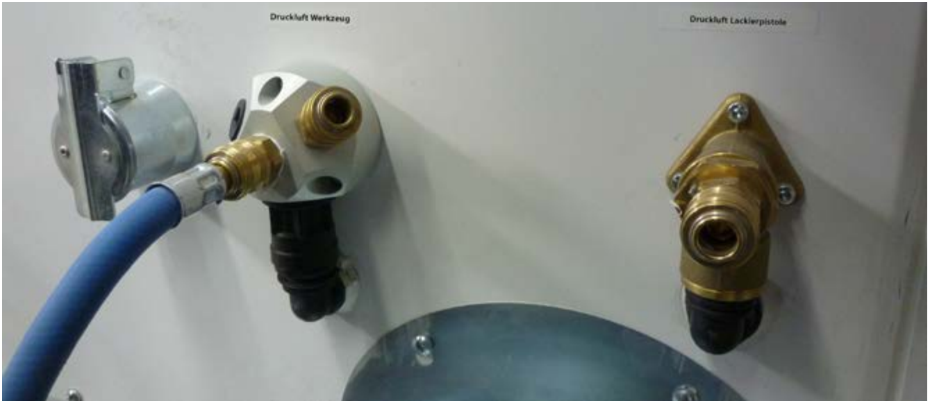
Abb. 9 Separate Druckluftversorgung für Handwerkzeuge und Lackierpistolen
