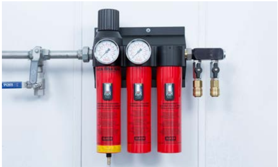
Abb. 13 Druckluft-Aufbereitung für fremdbelüftete Atemschutzgeräte mit Filterpatronenstandzeitanzeige
