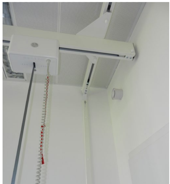
Bild 3: Portalmontage eines Patienten-Deckenlifters
