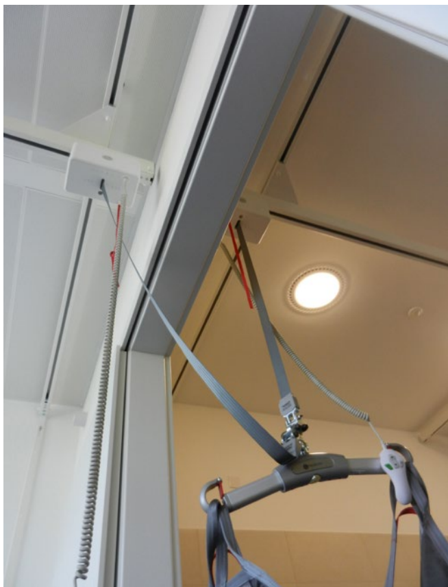
Bild 5: Deckenliftsystem mit Umhängemöglichkeit des Liftertuches am Türsturz
