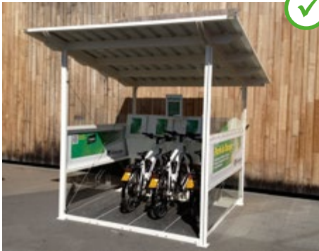
Abb. 17 Öffentliche Ladestation an einem Einkaufszentrum
