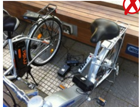
Abb. 18 Nicht empfehlenswert; Ladegeräte liegen auf dem Boden und sind über eine Mehrfachsteckdose unterverteilt (marktübliche Ladegeräte sind nur für die Benutzung in „trocknen Räumen“ geeignet)
