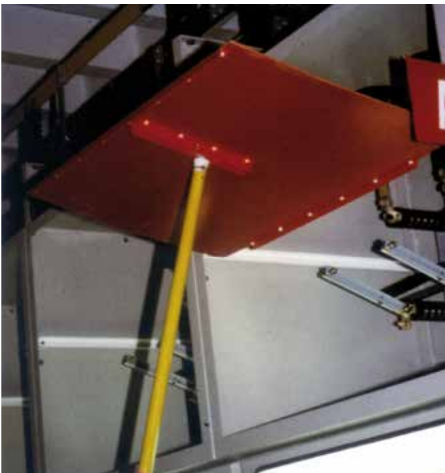
Bild 5-19: Die isolierende Schutzplatte im geöffneten Trenner bietet Schutz gegen zufälliges Berühren
