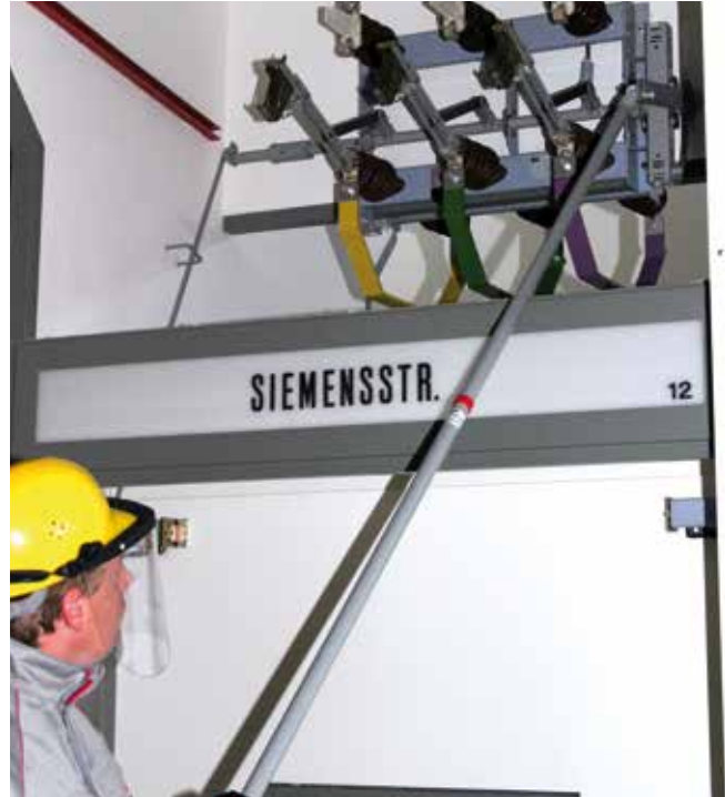
Bild 5-10: Elektrofachkraft beim Öffnen eines Hochspannungstrenners
