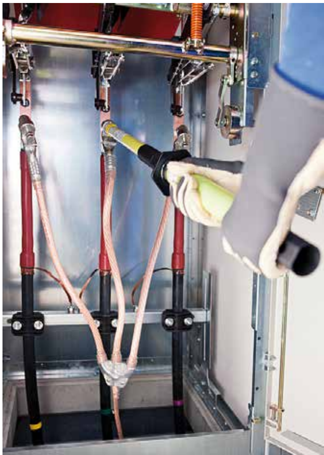
Bild 5-18: Erden und Kurzschließen nur mit kurzschlussstromfester Leitungsgarnitur
