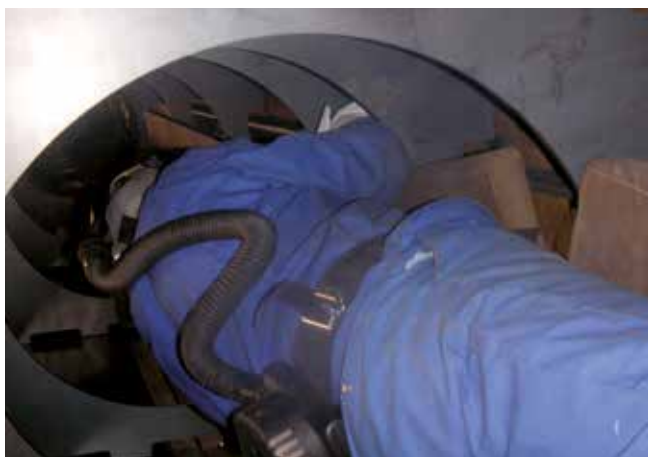
Bild 5-31: Beispiel für leitfähigen Bereich mit begrenzter Bewegungsfreiheit
