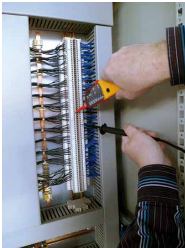
Bild 5-15: Feststellen der Spannungsfreiheit mit vorschriftsmäßigem Spannungsprüfer
