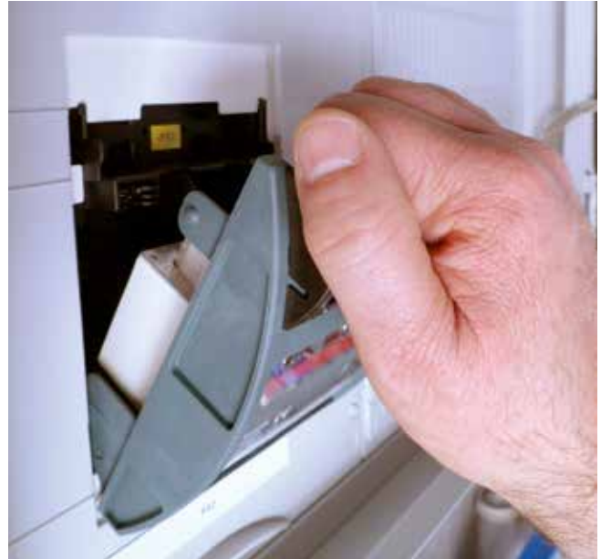
Bild 5-34: NH-Sicherungslasttrennschalter
