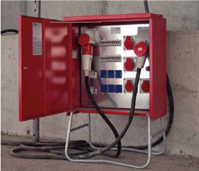
Bild 5-27: Baustromverteiler
