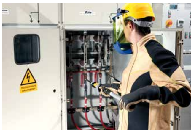
Bild 5-16: Feststellen der Spannungsfreiheit in einem Schaltfeld
