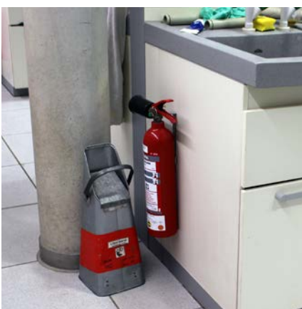
Abb. 6 Bereitgestellter Löschsand und Feuerlöscher
