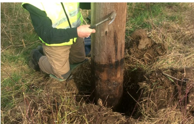
Abb. 7.4.5.1.a Abklopfen des Mastes im Bereich von -0,50 m bis +2,00 m Höhe;
