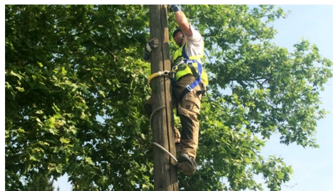
Abb. 7.4.5.1.d Abklopfen des zu besteigenden Bereiches
