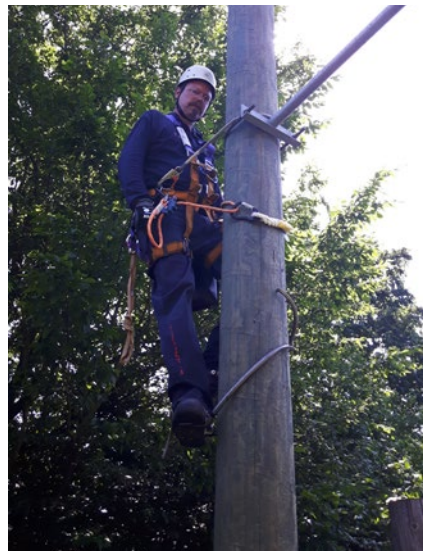
Abb. 7.8.2.b Anlegen des zweiten Halteseils oberhalb des Querriegels
