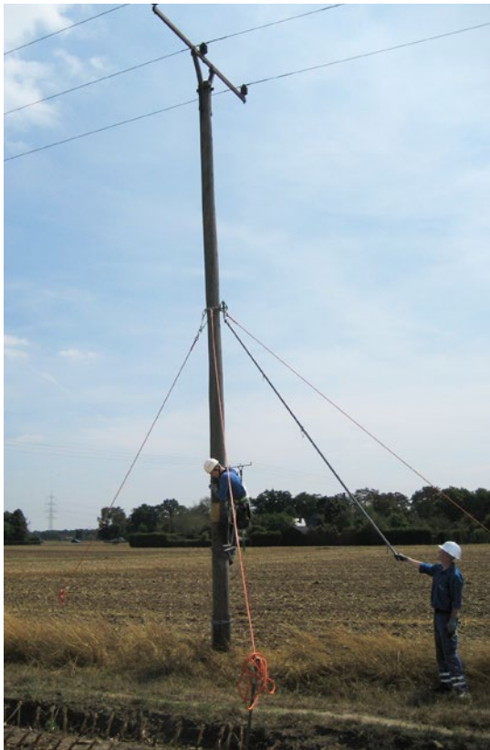
Abb. 7.6.1 Einsatz eines Mastsicherungsgerätes
