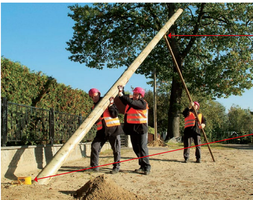
Abb. 5.2.2.1 Beispiel für ein manuelles Stellen eines Telekommunikations-Holzmastes unter Verwendung eines Mastabgleiters und einer Gabelstütze
