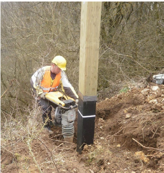
Abb. 5.3.1 Verdichtung von Füllgut in einer Mastgrube mittels kraftbetriebem Stampfer
