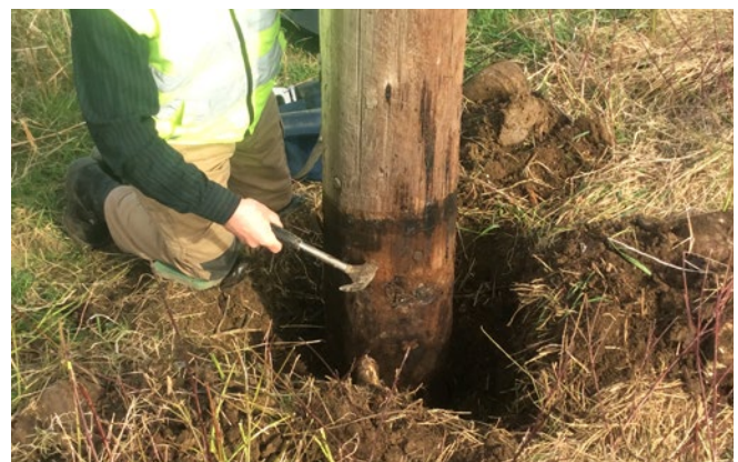
Abb. 7.4.5.1.b Das Abklopfen erfolgt auch im Bereich unter Erdgleiche am freigegebenen Mastabschnitt.
