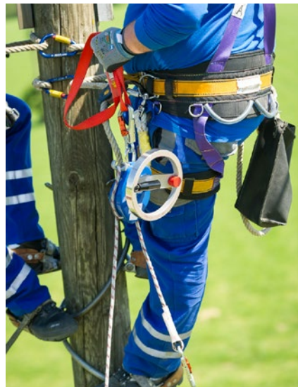
Abb. 10.b Der Retter steigt zu der zu rettenden Person auf und führt das Rettungssystem mit. Zur Befestigung des Rettungssystems am Mast muss er die zu rettende Person übersteigen.
