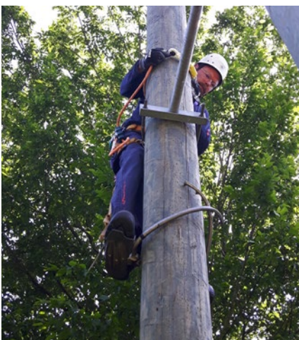
Abb. 7.8.2.d Entfernen des zweiten Halteseils
