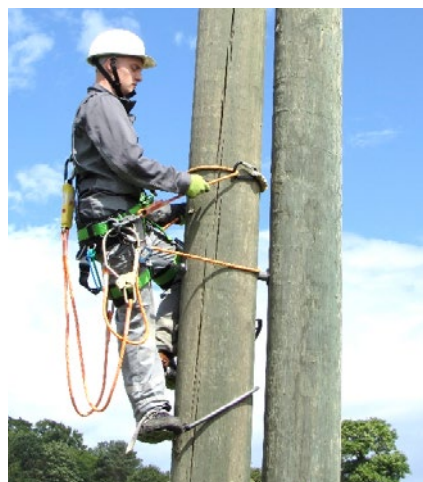
Abb. 7.8.2.e Beispiel für das Besteigen eines Doppelmastes: Die eingesetzte persönliche Schutzausrüstung gegen Absturz sowie deren Verwendung entspricht der für das Besteigen von A-Masten
