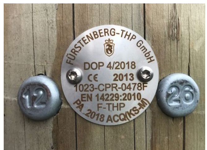
Abb. 2.2.1.1 Beispiel für eine ergänzende Kennzeichnung eines Mastes der Energieversorgung mit Angaben zu Mastlänge (12 m) und Mastfußdurchmesser (26 cm)
