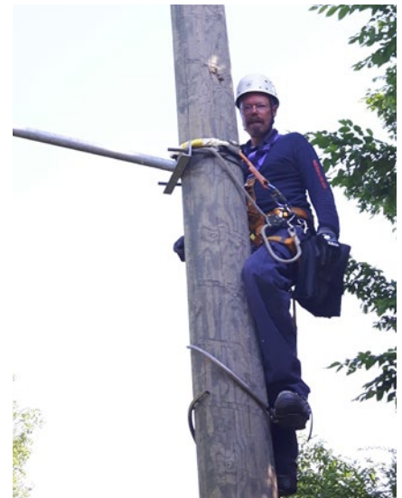
Abb. 7.8.2.c Umsetzen von Halteseil und Klemmseil über den Querriegel
