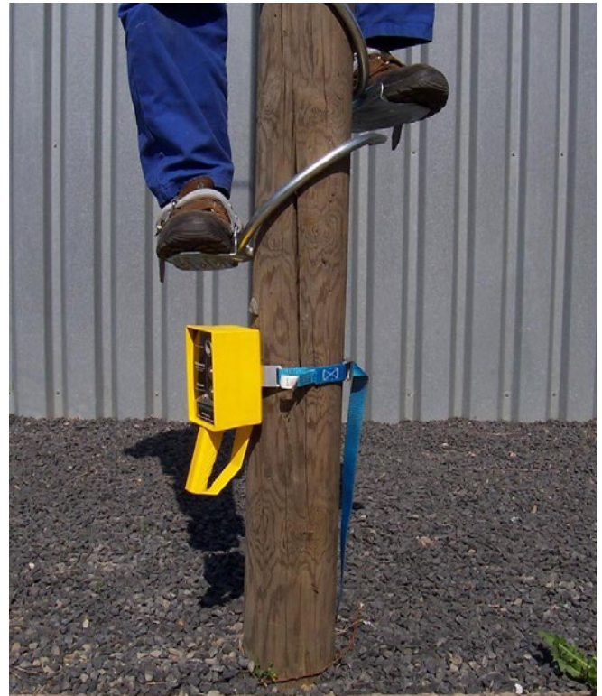
Abb. 7.4.5.4.b Der Mastbesteigesensor kommt auch beim Besteigen von und Arbeiten auf Masten zum Einsatz.
