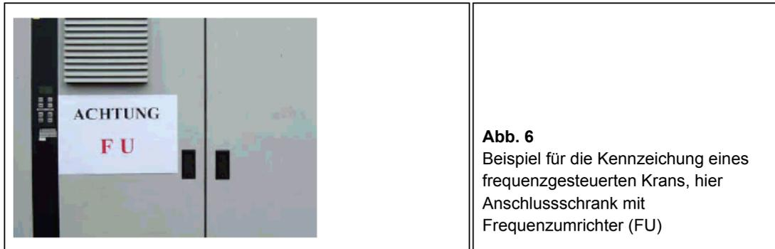
Frequenzgesteuerte Betriebsmittel verursachen aufgrund von EMV-Maßnahmen betriebsbedingte Ableitströme, die über den Schutzleiter abfließen. Die Ableitströme können die Fehlerstrom-Schutzeinrichtung (RCD) zur Auslösung bringen. Aus diesem Grund ist bei der Auswahl der Betriebsmittel darauf zu achten, dass diese möglichst geringe Ableitströme (weniger als 40 % des Bemessungsfehlerstromes) verursachen.
