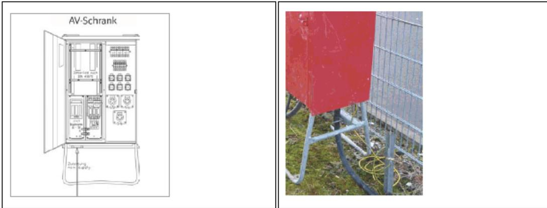
**Abb. 3** Versorgung einer kleineren Baustelle mit nur einem Anschlussverteiler-Schrank
