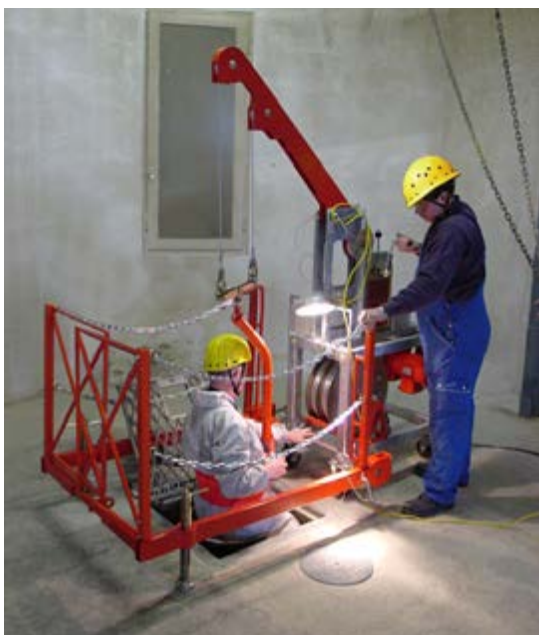
Abb. 8.12 Beispiel für das Einfahren in ein Silo mit Siloeinfahreinrichtung
