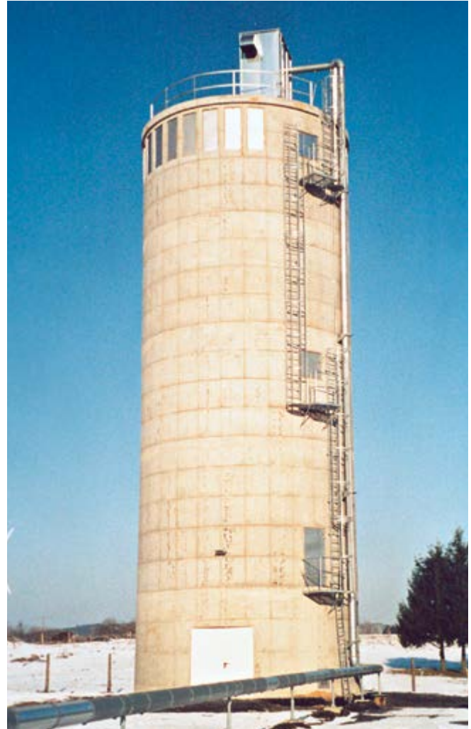
Abb. 9.11 Silo mit Berstscheiben oberhalb des max. Füllgutstandes
