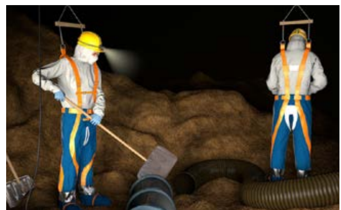
Abb. 7.17 Beispiel einer Arbeitssituation vor Ort im Silo
