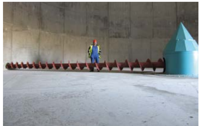
Abb. 6.9 Horizontale Austragsschnecke im Bodenbereich
