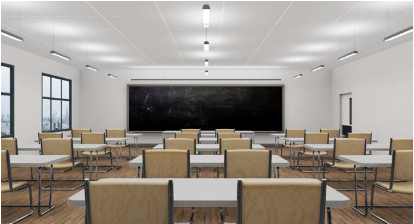
Abb. 14 Raumbezogene Beleuchtung im Unterrichtsraum und eine zusätzliche Tafelbeleuchtung
