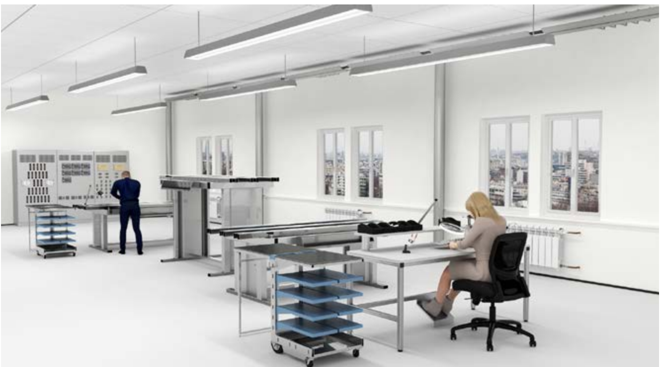
Abb. 16 Beispiel für eine auf den Bereich des Arbeitsplatzes bezogene Beleuchtung (500 lx) mit einer teilflächenbezogenen Beleuchtung (Arbeitsplatzleuchte) (zum Beispiel 750 lx)
