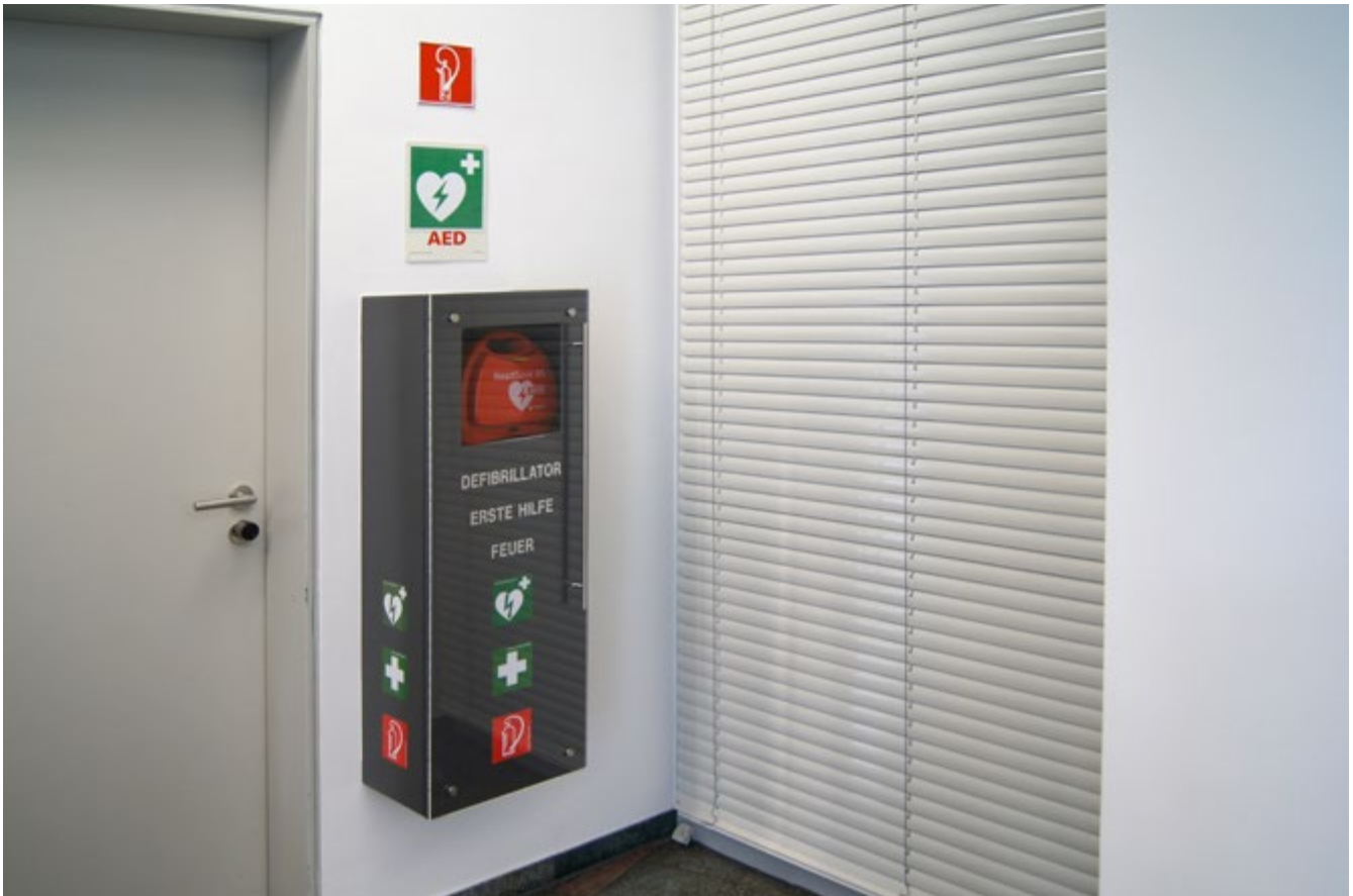
Abb. 2 Vor rauen Einflüssen geschützte Notfallsäule (mit Defibrillator, Erste-Hilfe-Material und Feuerlöscher)
