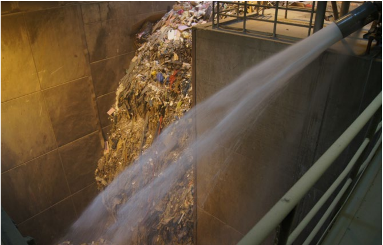
Abb. 14 Demonstration einer stationären Löschanlage im Müllbunker
