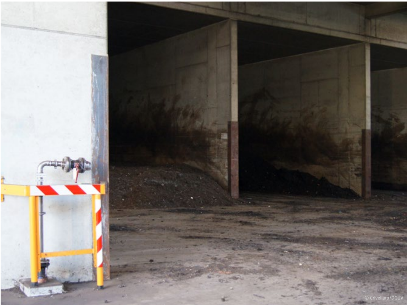
Abb.21 Belüftungsboxen für feste Gärreste mit Schlitzboden
