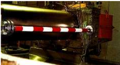
Abbildung 20: Sicherung von Einzugstellen an Walzen durch Schaltstange (nachgerüstete Altanlage)
