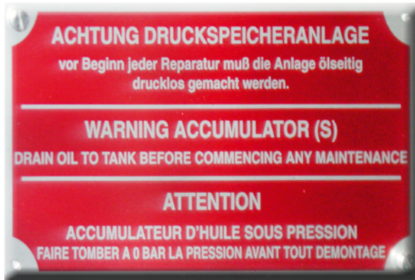
Abb. 21 Warnhinweis an Druckspeicher- anlage
