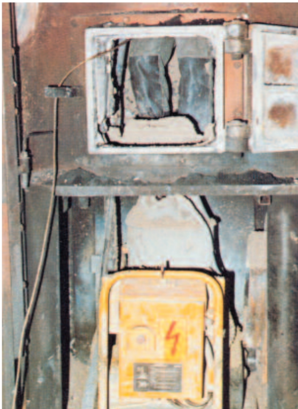
Bild 2-4: Arbeiten im Kupol- ofenschacht mit einer Hebebühne
