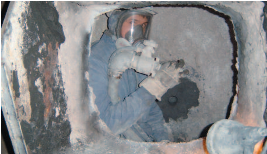
Bild 12-4: Atemschutz bei der Kupolofenreparatur
