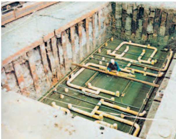
Bild 4-1: Arbeiten in einer Formgrube
