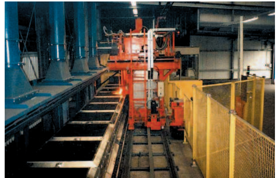
Bild 8-1: Gießautomat einer Formanlage
