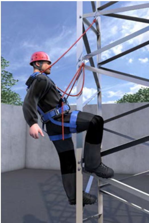
Abb. 7 Positionieren durch Verwendung von PSAgA/Absturzschutzsystem
