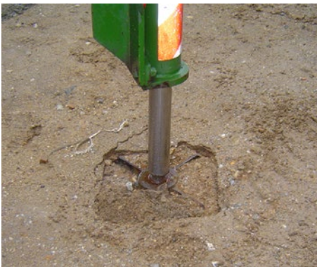
Bild 4-5 mangelhafte Lastverteilung
