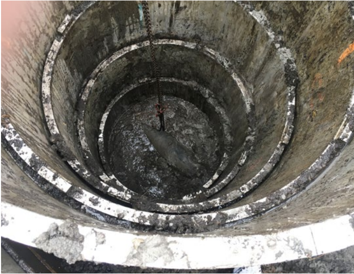
Abb. 13 Sicherung der Grabenwände mit nichtferromagne- tischen Verbau
